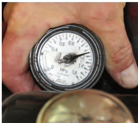
Dokonujemy ponownego pomiaru ciśnienia...
